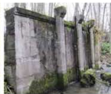
上川灌漑溝水門遺構
