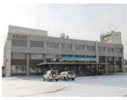
建築から49年が経過し老朽化が進む現在の庁舎
