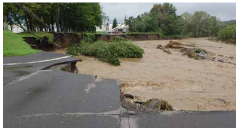
▲ 氾濫したパンケシントク川に削られて崩落した道路 (8月31日午前5時撮影 新得小学校北側の学校通)
