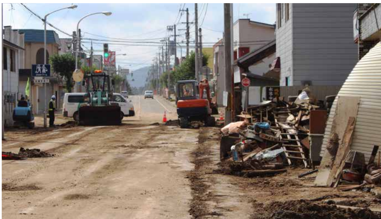
▲特に被害の大きな本通橋付近では、重機による瓦礫や土砂の撤去作業が続いた（9月15日撮影）
