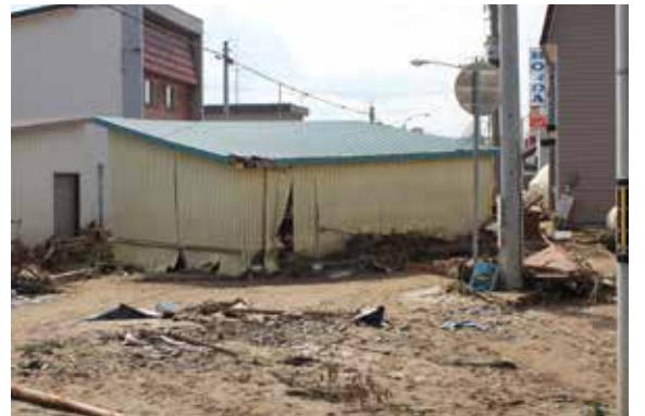
▲ 流された倉庫で封鎖された道路 (9月2日撮影 新得本通)
