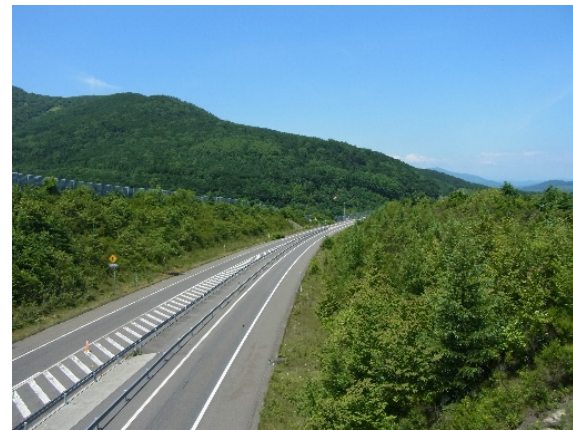
⑧候補地の橋からみた道東自動車道
